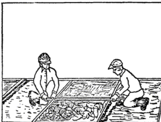
Рис. 6. Разравнивание раствора
