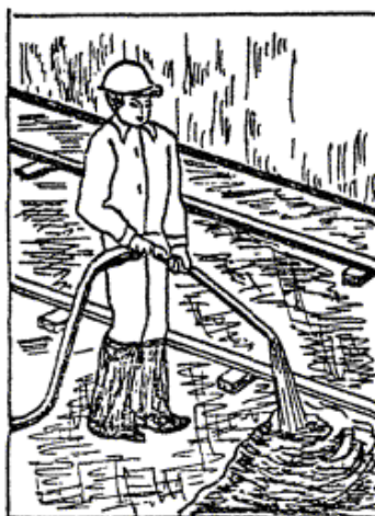
Рис. 5. Нанесение раствора соплом при устройстве полимерцементных стяжек
