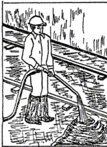
Рис. 5. Нанесение раствора соплом при устройстве полимерцементных стяжек
