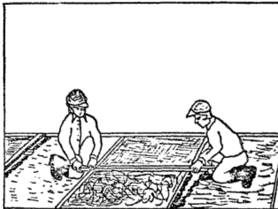
Рис. 6. Разравнивание раствора
